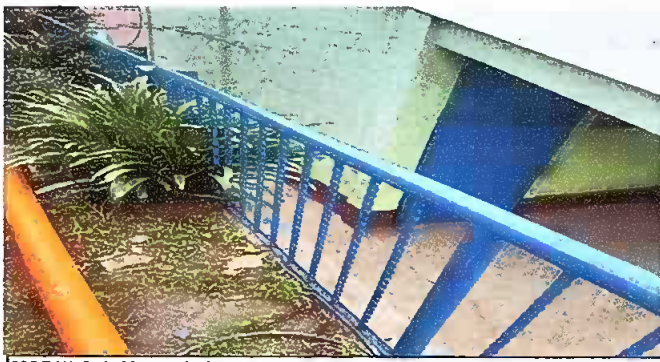
MODULO 4: Mantenimiento de baranda de metal
