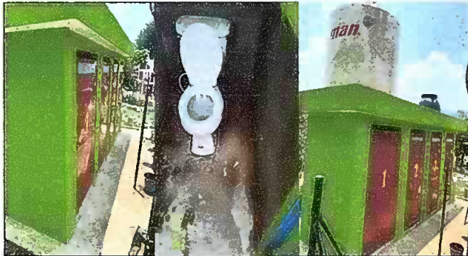
MODULO 1: Sustitucion de puertas de metal, sustitucion deposito de agua 1700 lts, sustitucion de inodoro.
