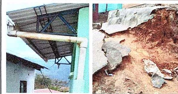
MODULO 4: Sustitucion de canal pvc, reparacion de muro perimetral de block.
