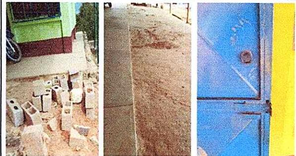
MODULO 3: Reparacion de muro perimetral, reparacion de plinta de concreto, sustitucion de chapa.
