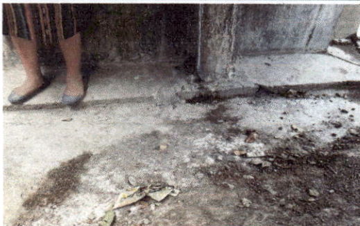
Foto 8: PISO DEL AREA DE COCINA Y ESTUFA DE LEÑA, ACTUALMENTE DE TIERRA.
