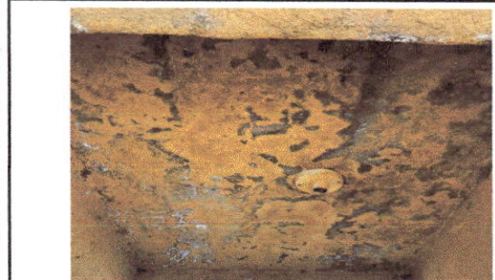
Foto 5: LA ACUMULACION DE HUMEDAD EN LOSA DE SANITARIOS POR FALTA DE PAÑUELOS.
