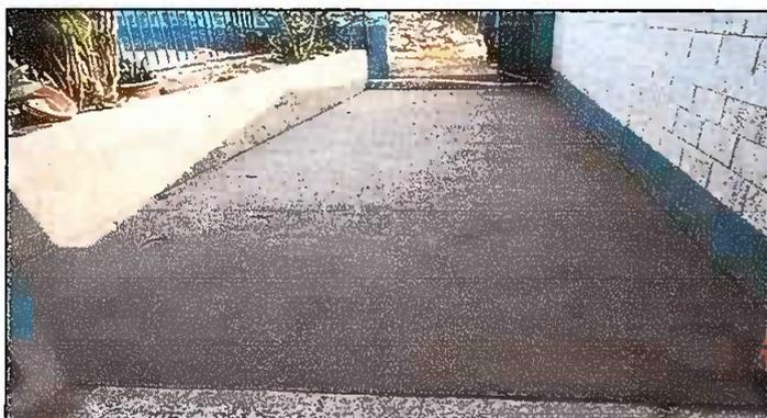
Foto 8: MODULO 16. REPARCIÓN DE PLANCHA DE CONCRETO DE PATIO
