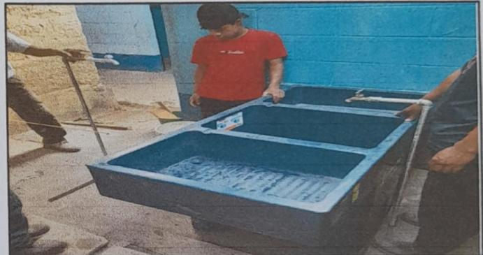
Foto 10: MODULO 19. INSTALACIÓN DE PILA DE PLASTICA DE 2 LAVADERAS
