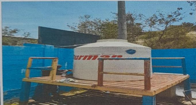
Foto 9: MODULO 18. SUSTITUCIÓN DE DEPOSITO DE AGUA 1700 LITROS
