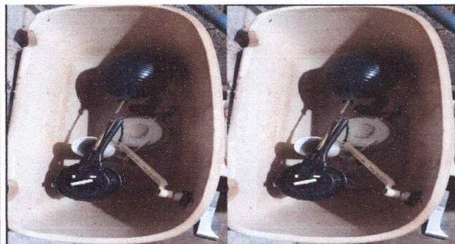
Foto 5: MODULO 10. SUSTITUCIÓN ACCESORIO INODOROS( contra llave, tubo de abasto y tanque)
