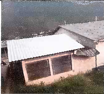
Módulo 2: Sustitución de láminas de cocina
