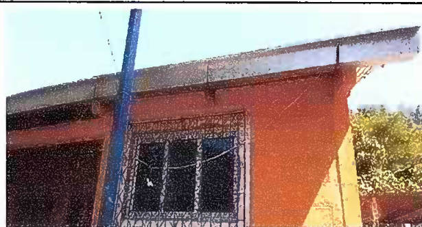
Foto 4: SUSTITUCIÓN DE CANAL DE 18 MT LÍNEALES
