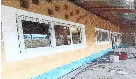
Foto 7: SUSTITUCIÓN DE VENTANA DE VIDRIO A PVC CON CORREDIZA
