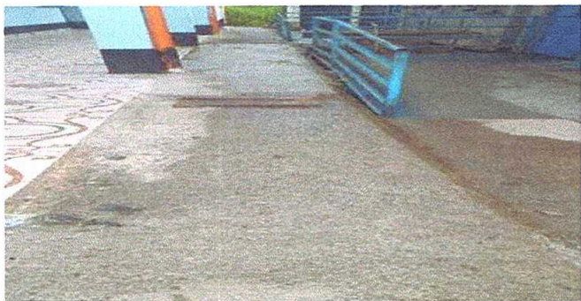
Foto 5: Reparacion de cuneta de concreto
