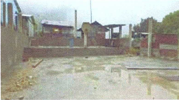
Foto 1: desinstalacion de lamina existentes
