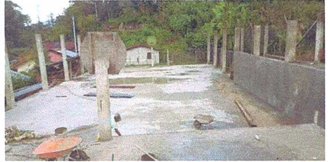
Foto 2: Reparacion de pisos torta de concreto
