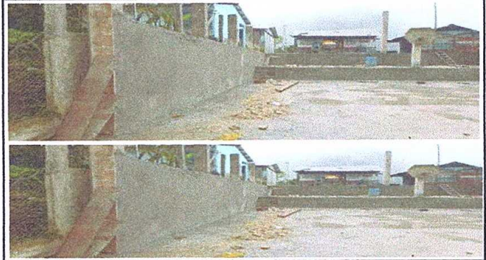
Foto 2: Reparacion de pisos torta de concreto
