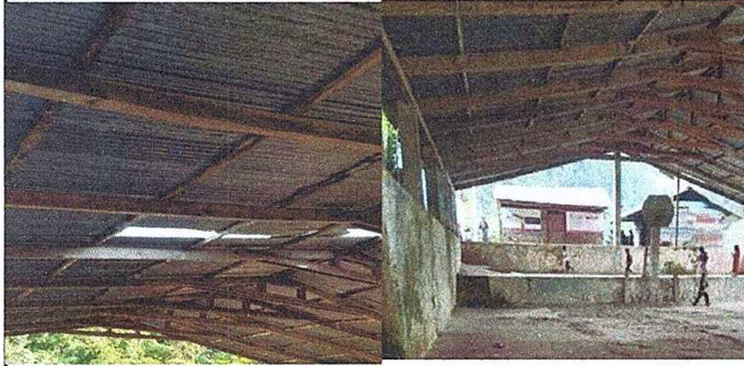
Foto1: desinstalacion de lamina existentes
