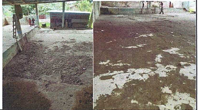
Foto 2: Reparacion de pisos torta de concreto
