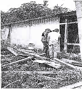
Foto1: Este es el proceso de cambio de techado y portante.
