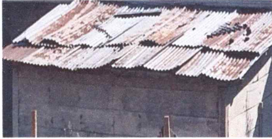
Foto1: Modulo 1, Sustitucion de lamina por lamana troquelada Aluzinc calibre 26
