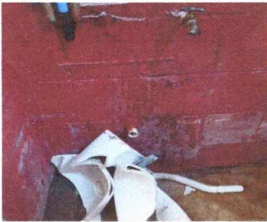
Foto 3: modulo 2 Inatacion de lavamanos y baños sanitario.
