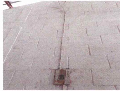
Foto Modulo 2. Reparacion de sistema electrico.
