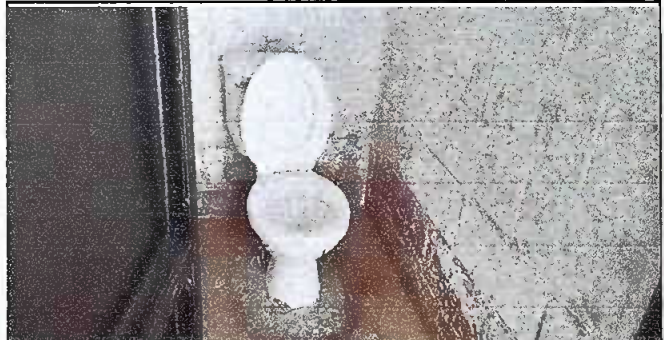
Foto 4: Sustitucion de sanitario aldoza
