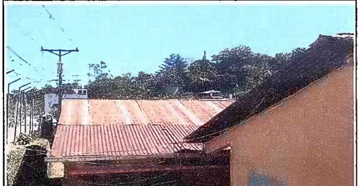
Foto 2: Cambio de techado de lámina y canales.
