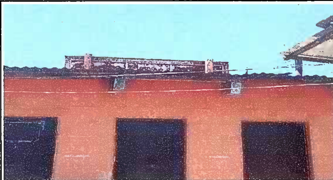
Foto 3: Instalación de canales y techado
