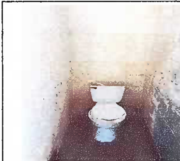
Foto 2: Sustitucion de inodoros y accesorios
