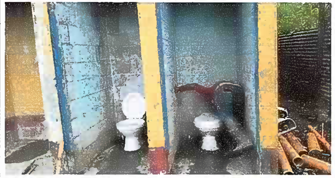
Foto 2: 10.3 SUSTITUCION INEDORO 10 UNIDADES
