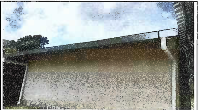
Foto 8: Sustitución de canal de metal
