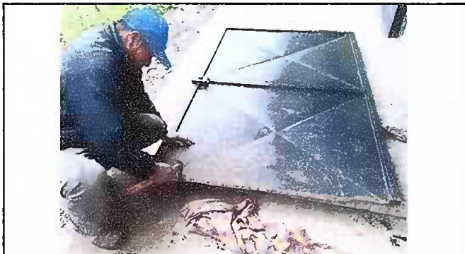
Foto 9: Mantenimiento a estructura, cambio de tubo
