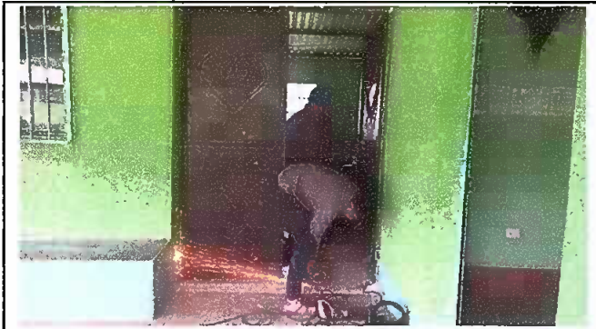
Foto1: Mantenimiento a portones de metal
