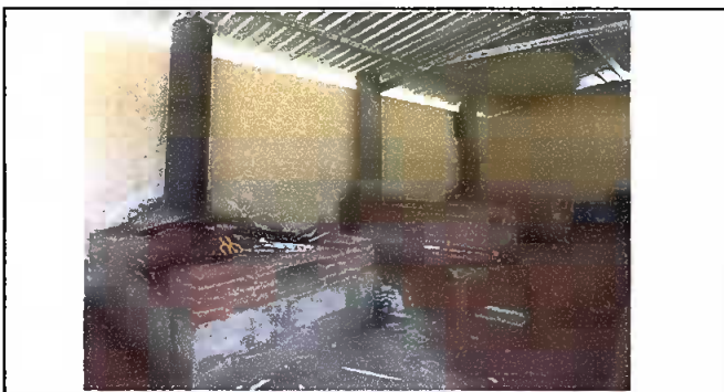
Foto 5: Mantenimiento a estufa rural
