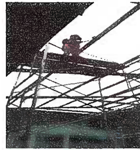
Foto 2: Agregado de estructura metálica.
