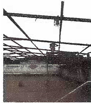
Foto 4: Pintura de estructuras metálicas
