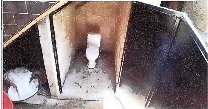
Sustitución de inodoro, reparación de muro de block e instalación de puerta.
