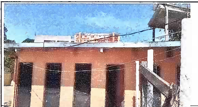
Instalación de láminas aluzinc y estructuras de metaql
