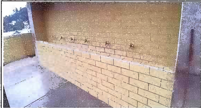
Instalación de chorros.
