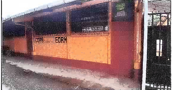
Pintura general, interior y exterior
