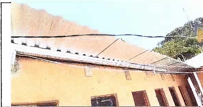
Instalación de láminas aluzinc y estructuras de metal
