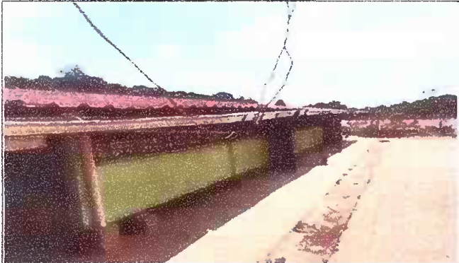
Foto 3: Sustitución de canales y perta de metal Modulo 3
