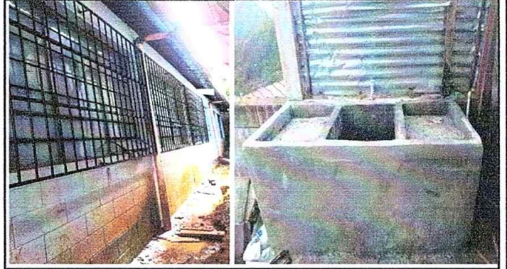
Foto 2 de Modulo 1: Suministro y colocación de balcon de hierro. Sustitución de pila de concreto.
