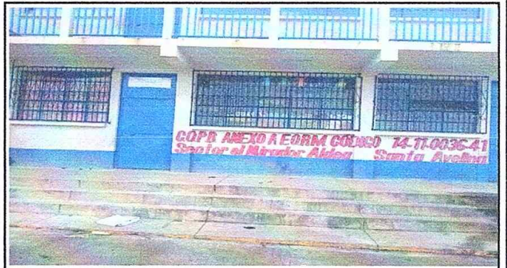
Foto 4 Modulo 3 Suministro y colocación de balcon de hierro en ventana.
