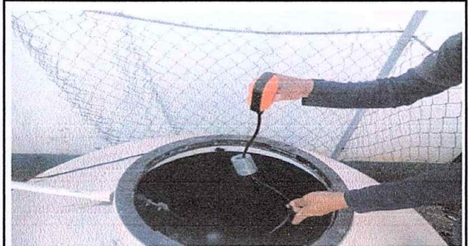
foto 8 de Modulo 4 : Sustitución de accesorios de deposito de agua.
