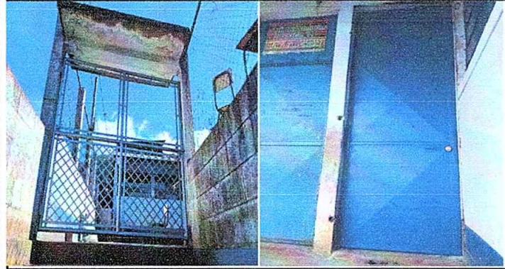
Foto 1 de Modulo 1: Mantenimiento a estructura de porton de metal (lijado, sepillado sujeciones, aplicación de pintura y cambio de malla hg). Sustitucion de puertas de metal por metal.
