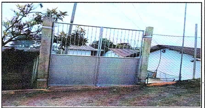
Foto 6 del Modulo 4 Sustitución de porton de metal.
