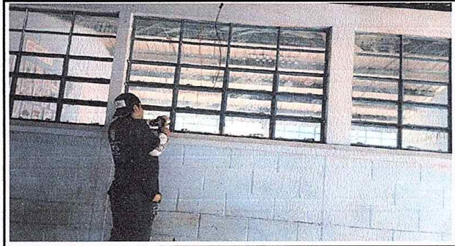
Foto 10 de Modulo 4: Sustitución de vidrios de ventanas
