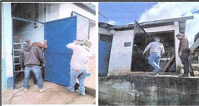
Foto 3 del Modulo 2. Sustitución de puertas de metal por metal.
