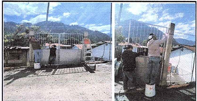
Foto 6 del Modulo 4 Sustitución de porton de metal.
