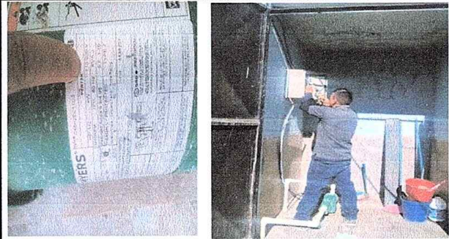
Foto 7 de Modulo 4: Reparación de bomba de agua.
