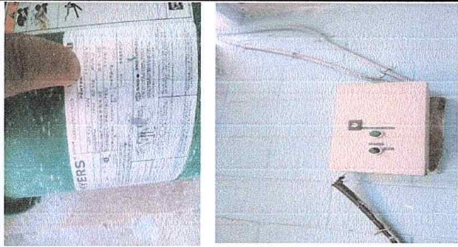
Foto 7 de Modulo 4: Reparación de bomba de agua.
