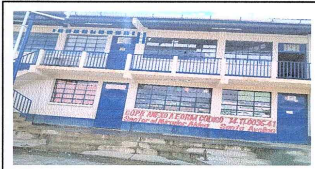
Foto 4 Modulo 3 Suministro y colocación de balcon de hierro en ventana.
