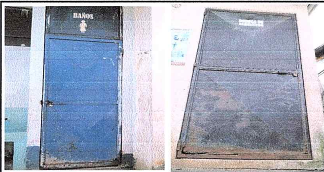
Foto 3 del Modulo 2. Sustitución de puertas de metal por metal.
