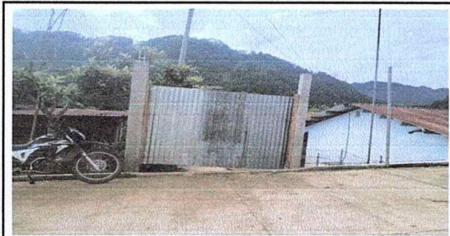
Foto 6 del Modulo 4 Sustitución de porton de metal.
