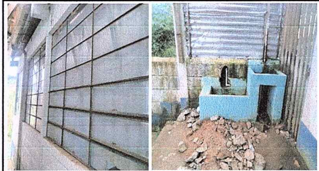
1 Foto 2 de Modulo 1: Suministro y colocación de balcon de hierro. Sustitución de pila de concreto.
