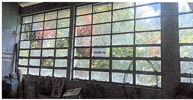
Foto 10 de Modulo 4: Sustitución de vidrios de ventanas
