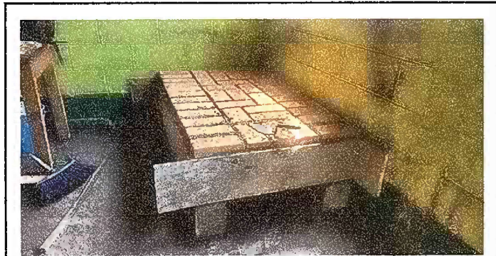
Foto1 Módulo 3: Sustitucion de estufa rural ( completa ) incluye chimenea y plancha de metal
