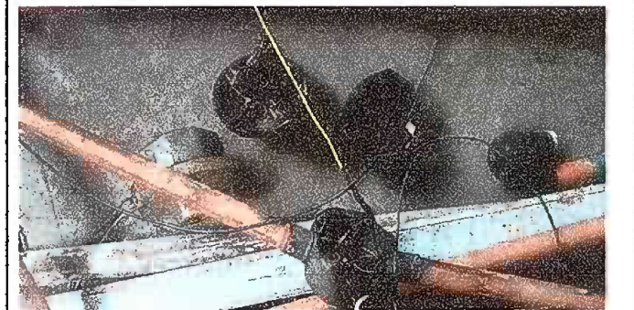
Foto 6 Modulo1: Sustitución de ducto eléctrico + accesorio
