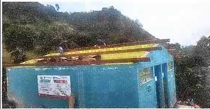
Foto 4 Módulo 2: Mantenimiento a estructura de soporte de metal.
