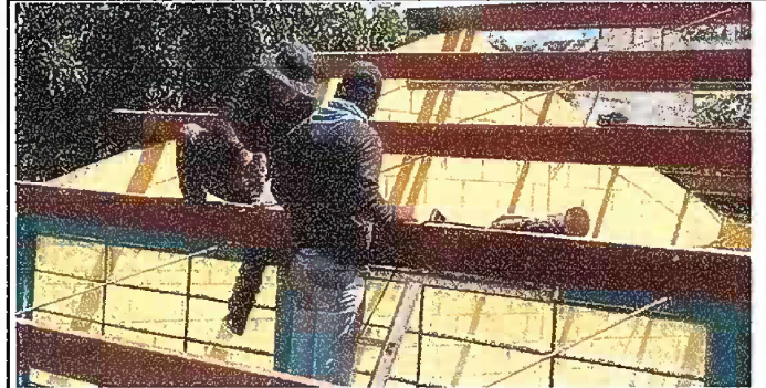
Foto 4. Módulo 1: Mantenimiento a estructura de soporte de metal.
