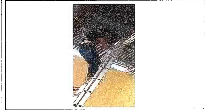
Foto 11. Módulo 1: Sustitución de focos ahorradores.
