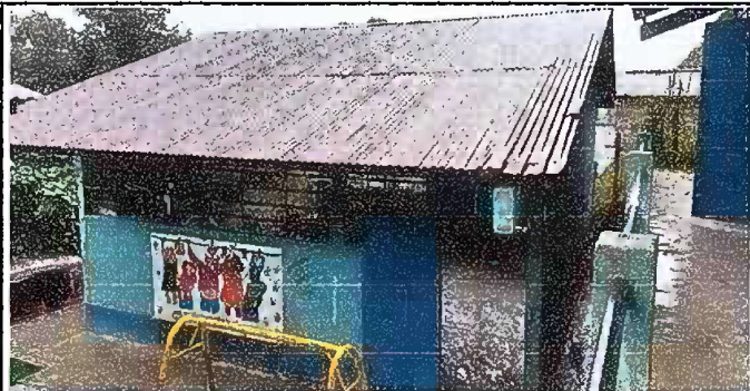
Foto 1. Módulo 1: Sustitucion de lámimina, por lámina troquelada aluzinc calibre 26.
