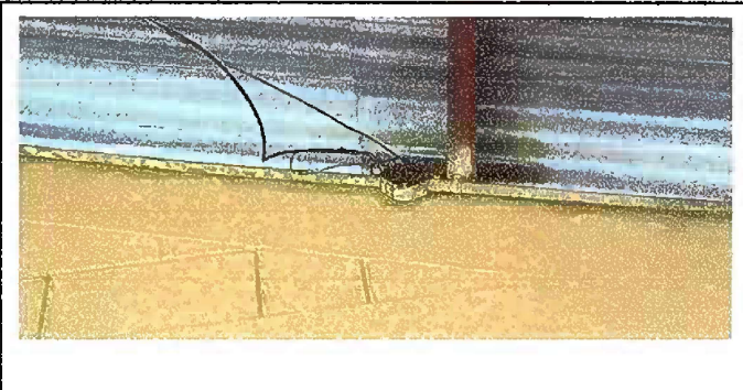
Foto 6 Modulo1: Sustitución de ducto eléctrico + accesorio
