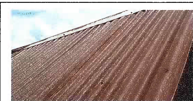
Foto 3. Módulo 1: Sustitucion de capote de lamina para lámina troquelada
