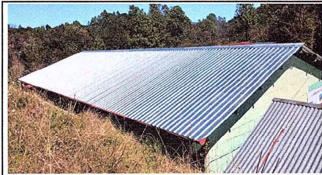
fotoграфия 1 MÓDULO 1: Sustitucion de laminas por lamina troquelada aluzinc calibre 26
