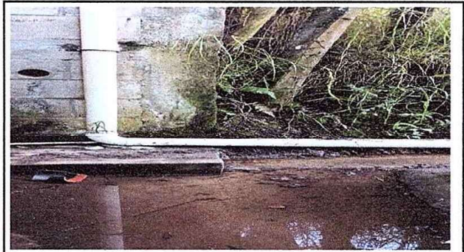
fotoграфия 4 MÓDULO 1: Sustitución de bajada de agua pluvial de PVC por tubo PVC "3"
