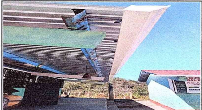
fotoграфия 2 MÓDULO 1: Sustitución de canal PVC
