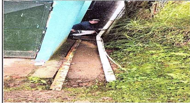
fotografía 4. MÓDULO 1: Sustitución de bajada de agua pluvial de PVC por tubo PVC "3"
