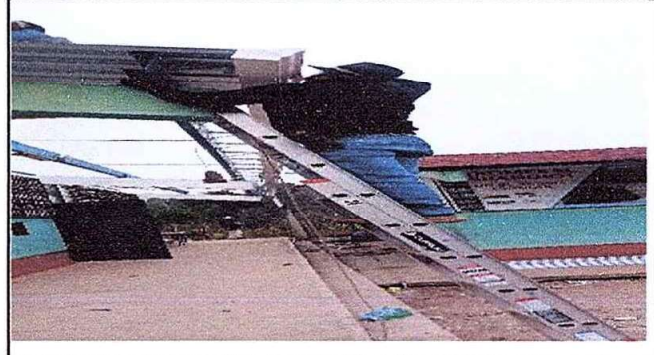
fotografía 2. MÓDULO 1: Sustitución de canal PVC
