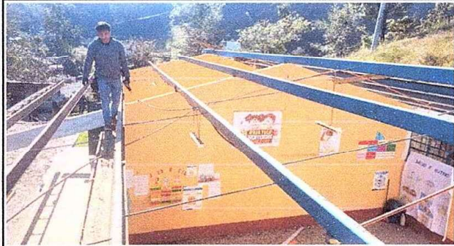
fotografía 1. MÓDULO 1: Sustitución de laminas, por lamina troquelada aluzinc calibre 26
