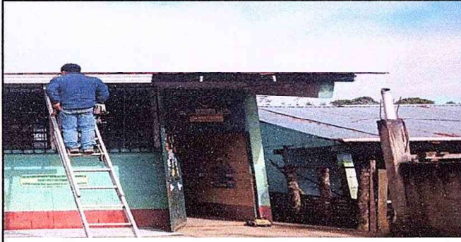
foto 7. MÓDULO 2: Sustitución de bajada de agua pluvial de PVC por tubo PVC 3".
