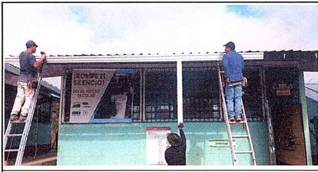
fotografía 5. MODULO 2: Sustitución de canal PVC.
