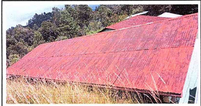
fotografia 1 MÓDULO 1: Sustitucion de lamina, por lamina troquelada aluzinc calibre 26
