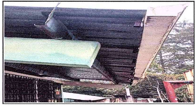
fotografia 6 MÓDULO 2: Sustitución de soporte o pescante de metal para canal
