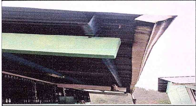
fotografia 3 MODULO 1: Sustitución de soporte o pescante de metal para canal
