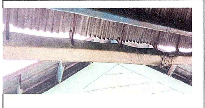
fotografia 2 MÓDULO 1: Sustitución de canal PVC
