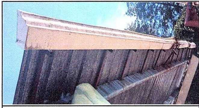
fotografia 5 MODULO 2: Sustitución de canal PVC
