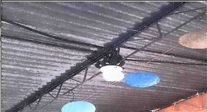
SUSTITUCION DE LAMINA ACANALADA
