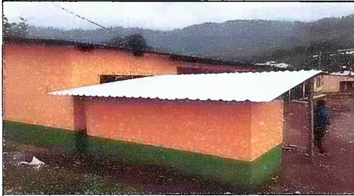
Foto 1: SUSTITUCION DE LÁMINA, SOPORTE Y ELEMENTOS DE FIJACION
