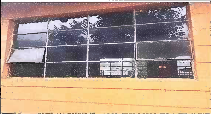
Foto1: SUSTITUCION DE VIDRIOS
