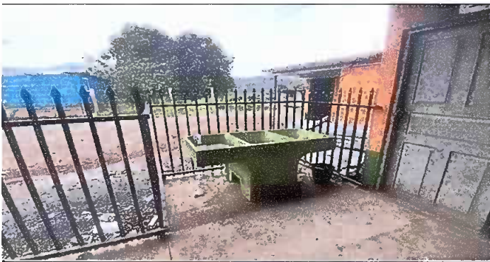
Foto 5: sustitucion de pila de cemento de dos lavaderos
