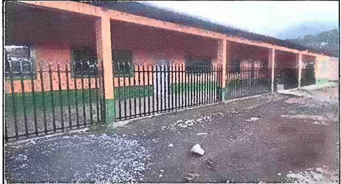
Foto 4: SUSTITUCION DE BARANDAS
