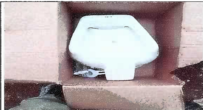
INSTALACION DE MINGITORIO
