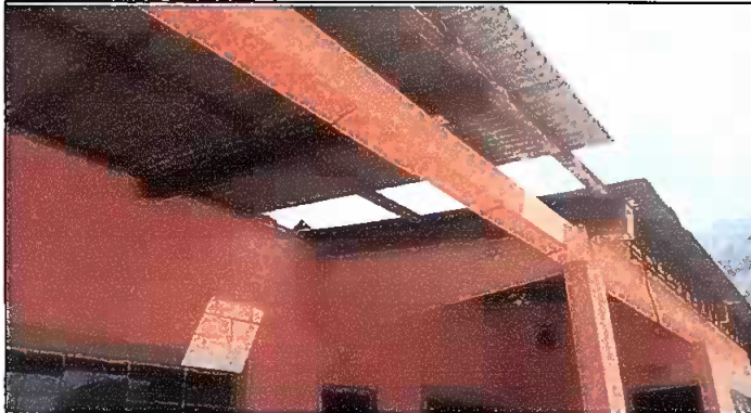
SUSTITUCION DE LAMINA ACANALADA
