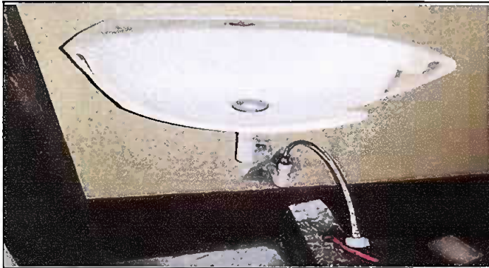
Foto 1: SUSTITUCION DE LAVAMANOS
