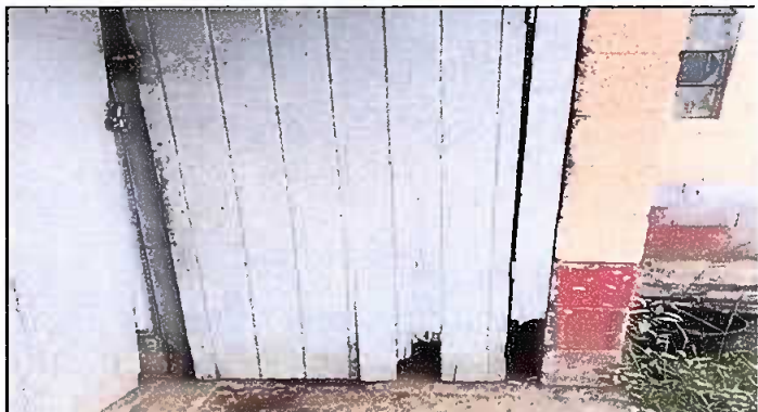
Foto 4: SUSTITUCION DE PUERTAS DE SANITARIO
