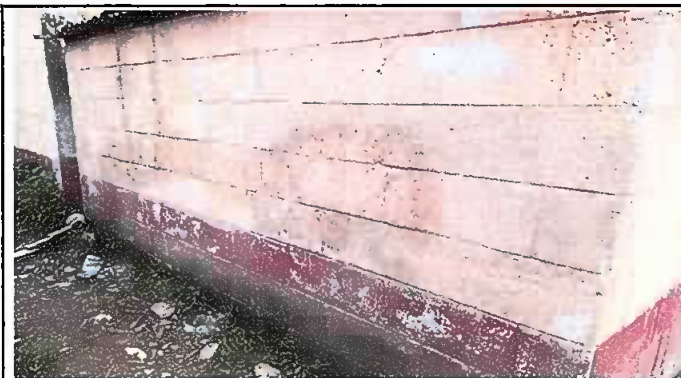
PINTURA EN MUROS INTERIORES Y EXTERIORES
