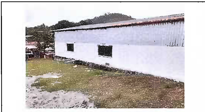
Módulo 1: Suministro e instalación de repello.
