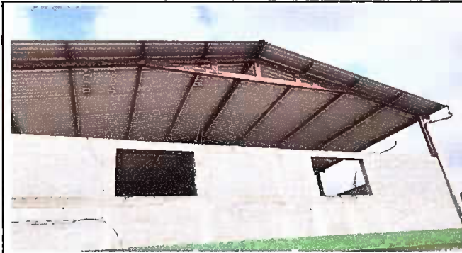
Módulo 1: Suministro e instalación de ventanas. Suministro e instalación de balcones.
