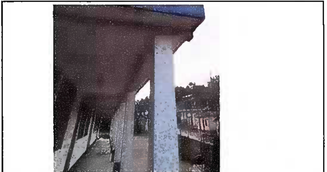
Módulo 1: Suministro de canales y bajada pluvial.
