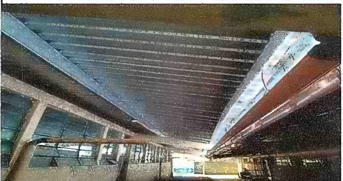
Foto 4: Remosamiento finalizado canales, tubos colocados
