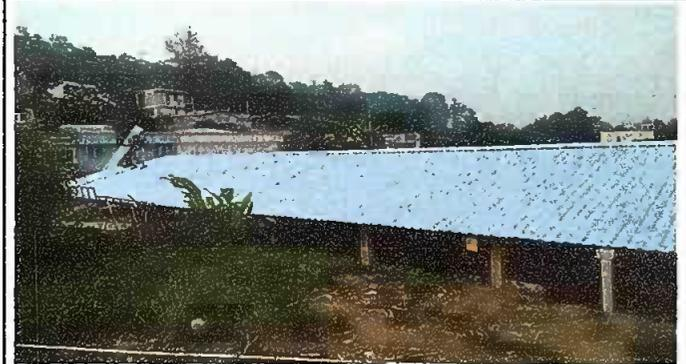
Foto 2: Colocacion de Capotes y laminas instaladas
