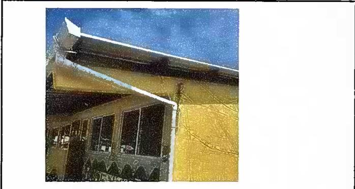
Foto 3: Sustitución de canales. (Despues)
