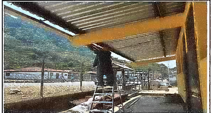
Foto 2: Sustitucion de canales (durante)
