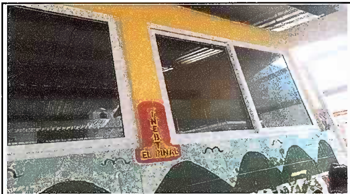
Foto 3: Sustitucion de ventanas. (durante)
