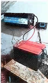
Foto 3: Sustitucion de controladores de carga Modulo 1
