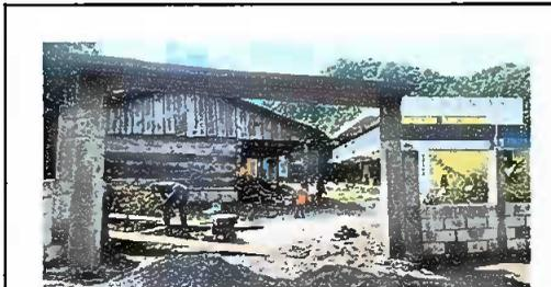
Foto 15: Sustitución de columna Módulo 4
