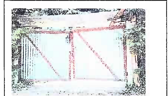
Foto 14: Sustitución de portón de metal Módulo 4
