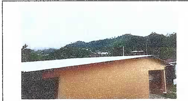
Foto 1: Cambio de Techado
