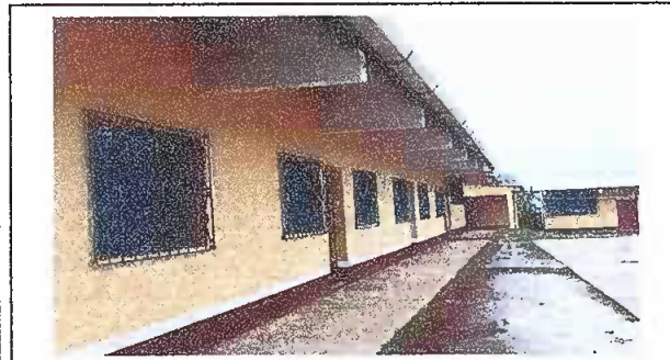
Foto 3: Reparación de Balcones
