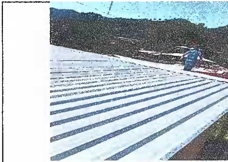
Foto 4: Colocación de techado
