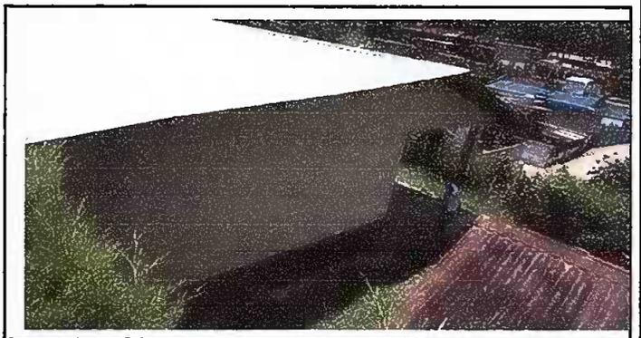
Foto 6: Techo de láminas troqueladas en vez de metal
