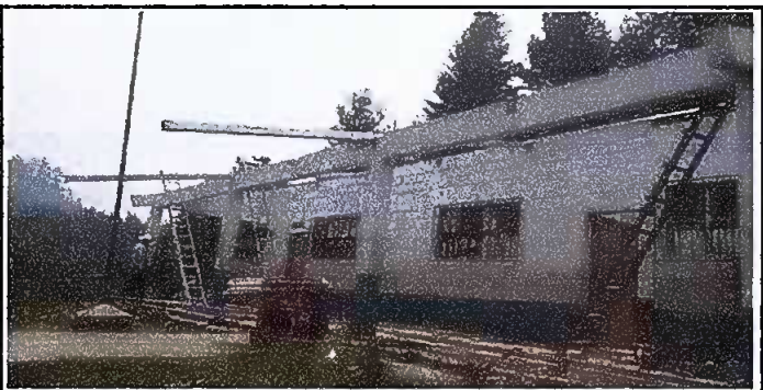
Foto 5: colocacion de costaneras galvanizadas en ves de maderas
