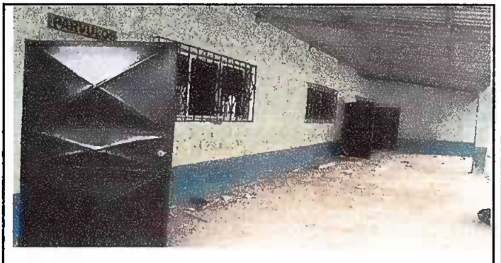
Foto 4: Puertas colocadas ya de metal.
