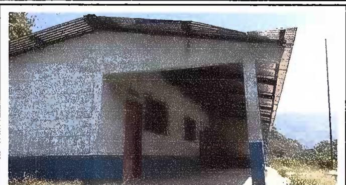
Foto 2: fotografía tomada donde se observa las puertas de madera y laminas en mal estado.
