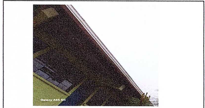
Foto 4: MODULO 1 Sustitucion canal pvc
