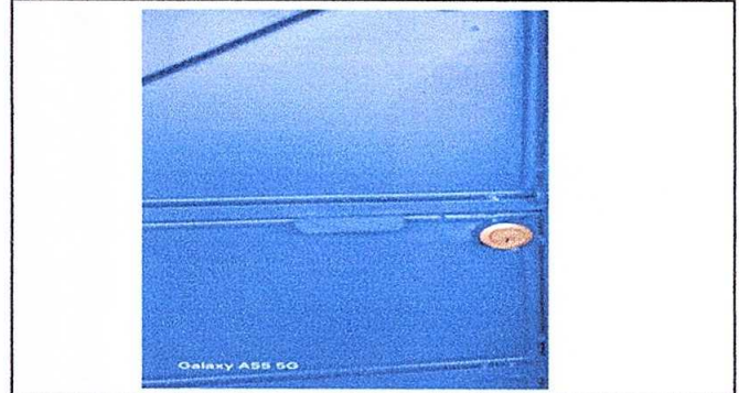
Foto 2: MODULO 1 Sustitucion de chapa
