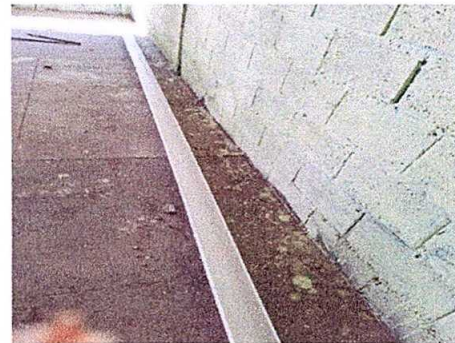
Foto 4: MODULO 1 Sustitucion canal pvc
