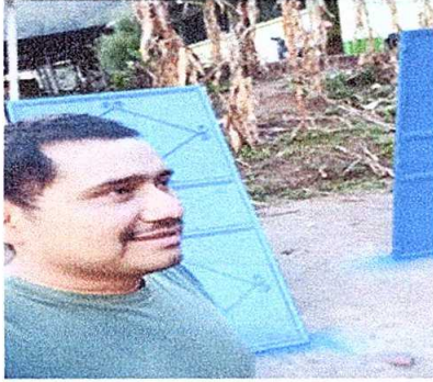
Foto1: MODULO 1 Mantenimiento a estructura de puerta (lijado,cambio de tubo,cepillado, sujecion, aplicacion de pintura)
