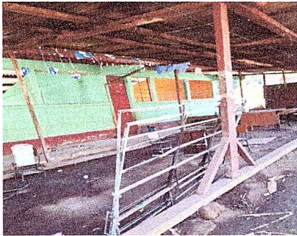
Foto 3: MODULO 1 Sustitucion de ventana
