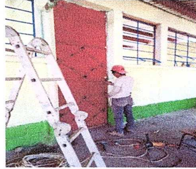
Foto 2: MODULO 1 Sustitucion de chapa
