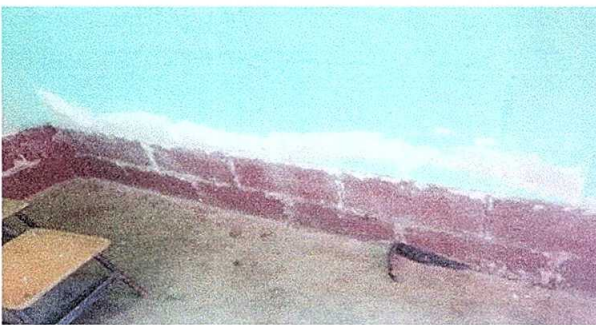
Foto 5: MODULO 2 Pintura en muro exteriores e interiores.
