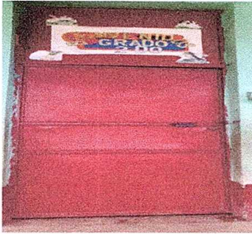
Foto1: MODULO 1 Mantenimiento a estructura de puerta (lijado, cambio de tubo, cepillado, sujecion, aplicación de pintura)
