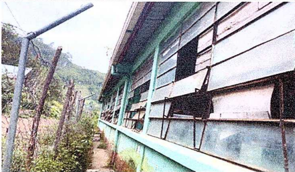
Foto 3: MODULO 1 Sustitucion de ventana
